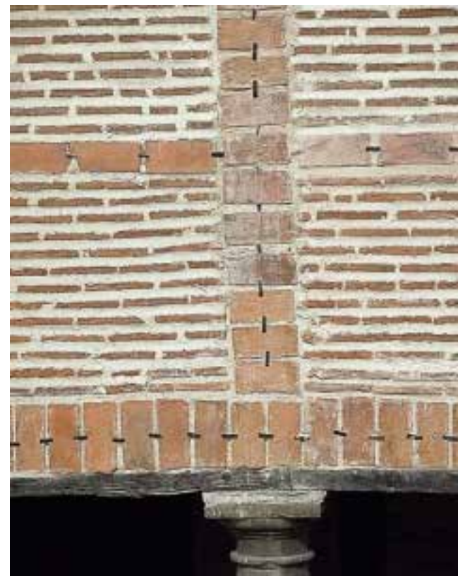
Armazoiaren zura ezkutatzen duten adreilu-plaken xehetasuna.
