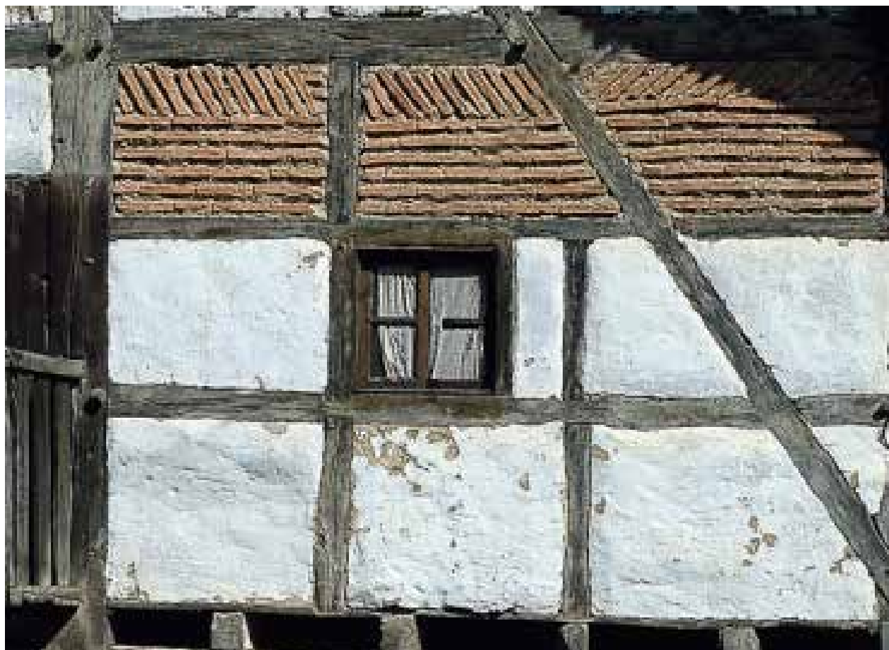
XVIII. mendeko baserria, askotan, egurrezko eta adreiluzko armazoia duen obra da, aberatsa baino ederragoa. Kortezubiko Zierre baserria.
