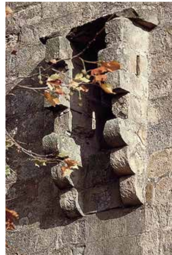
Defentsa bertikalerako lapur-zuloa. Elementu horiek komun gisa ere balio dute.
