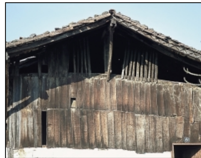
Detalle del cierre con madera del piso alto del caserío Artabene en Bedia.
