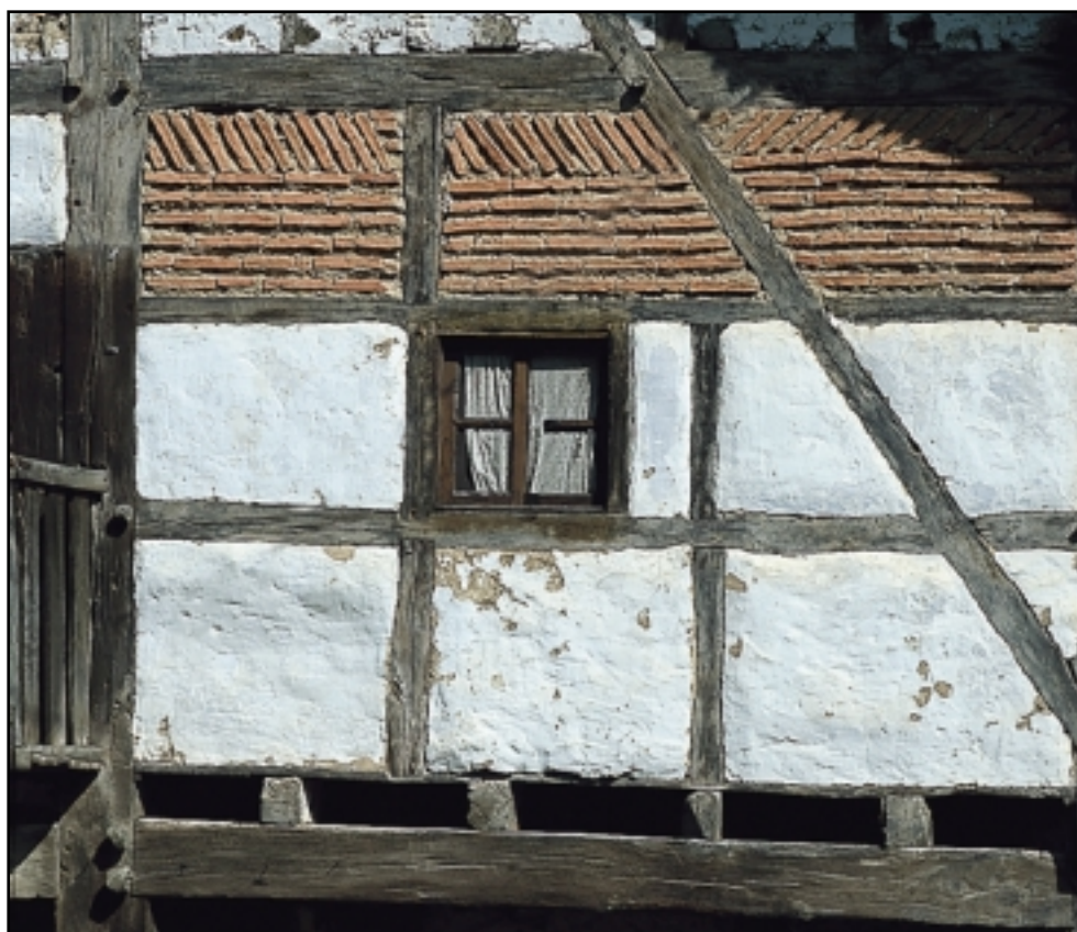
El caserío del siglo XVIII es con frecuencia una obra de entramado de madera y ladrillo más bello que rico. Caserío Zierre en Kortezubi.
