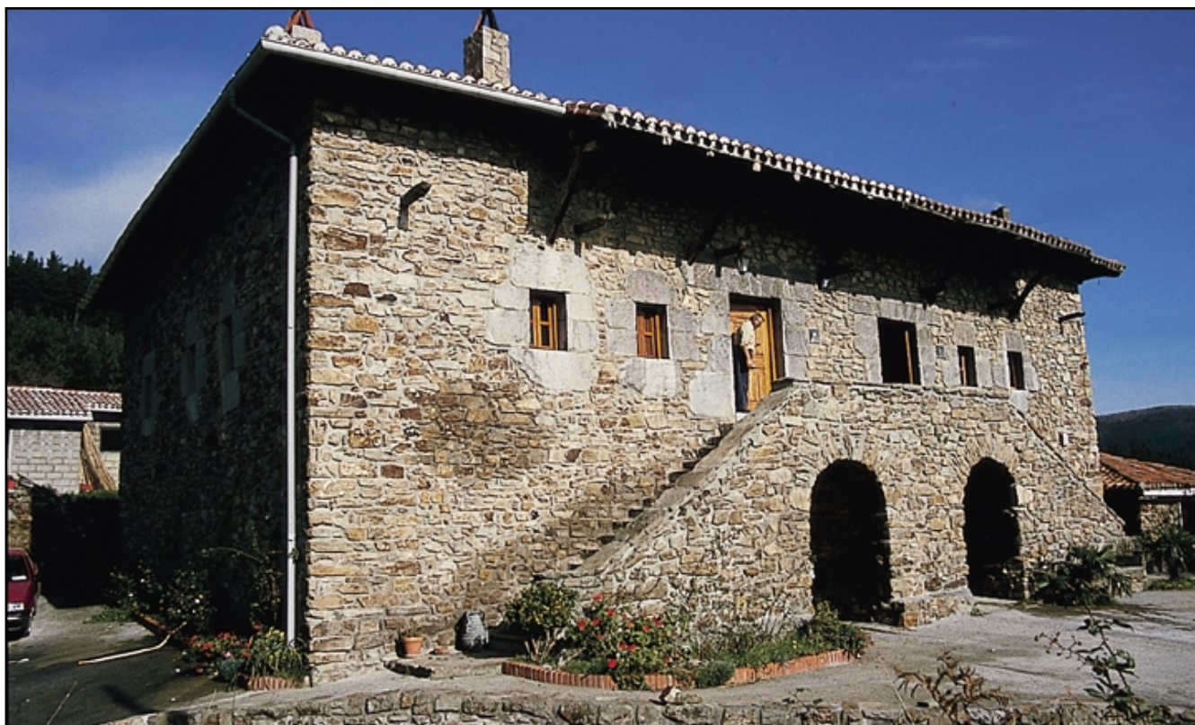
Caserío ganadero de tipo cúbico, con patín de piedra. Caserío Zollourruti en Zollo.
