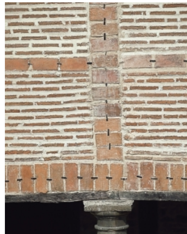
Detalle de las placas de ladrillo que ocultan las maderas del entramado.
