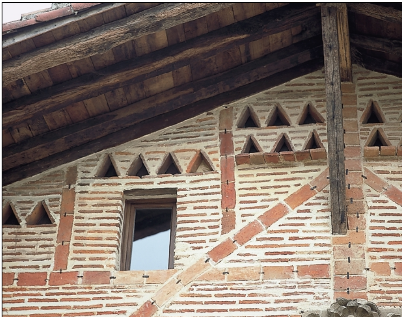
Varios triángulos (de "palomar") en la ganbara del caserío Palacio o Zabala de Izurtza. Se aprecian los clavos para sujetar los ladrillos.
