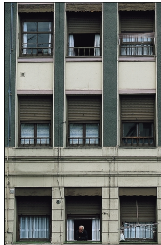
Grupo Torre Urizar en Bilbao. Detalle de fachada.
