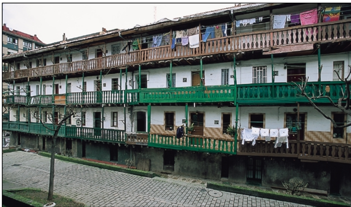
Casa de corredor de La Galana en Sestao. Vista de conjunto.
