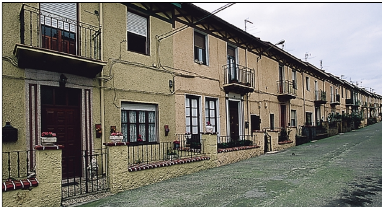
Cooperativa La Aurora en Sestao. Vista de conjunto.
