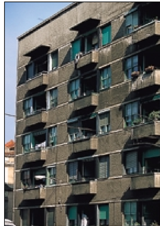
Grupo Solokoetxe II en Bilbao. Detalle de la fachada.
