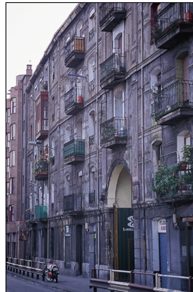
Edificio de viviendas de la fábrica Vizcaya en (1890). Vista de conjunto.
