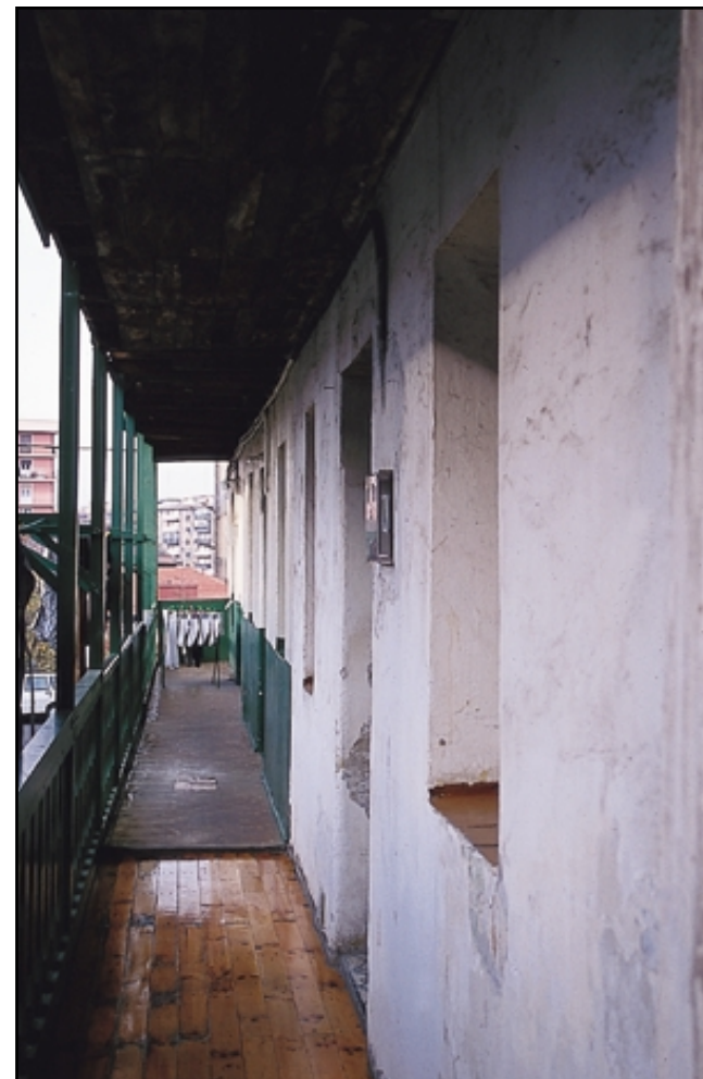
Detalle del balcón corredor de La Galana.
