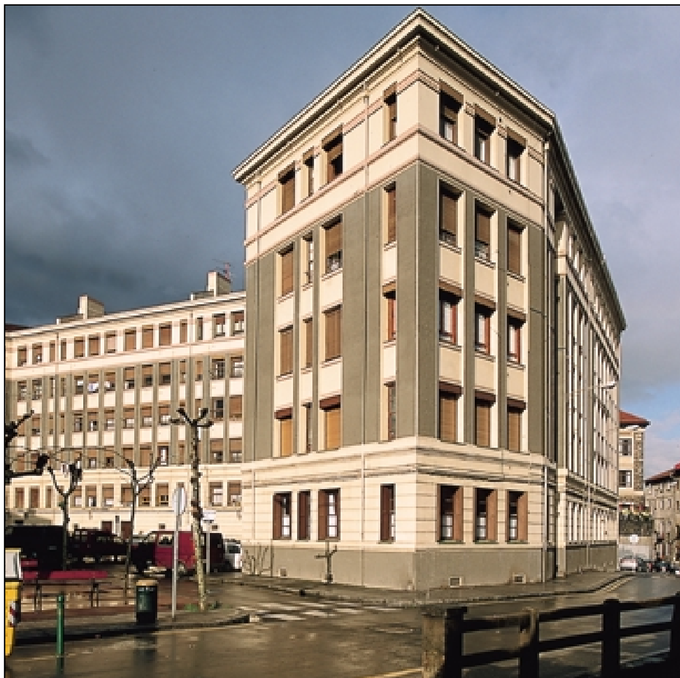
Grupo Torre Urizar en Bilbao. Vista parcial.
