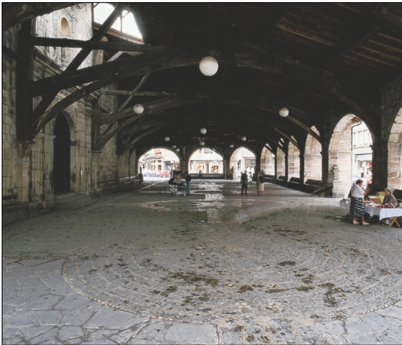
El pórtico de Santa María de Uribarri de Durango es un amplio espacio construido para el servicio del templo. En este caso es una impresionante obra de grafostática en madera.
